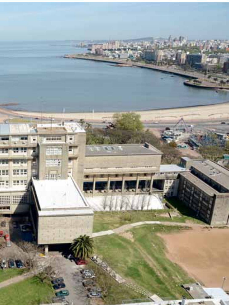
Foto: Área de Comunicación Fing
