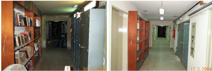
Figura H.9: El antes y el después del corredor del subsuelo, reacondicionado en 2004.
