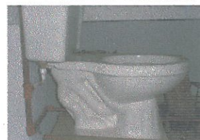
Laboratorio e instalación se sanitarias internas
