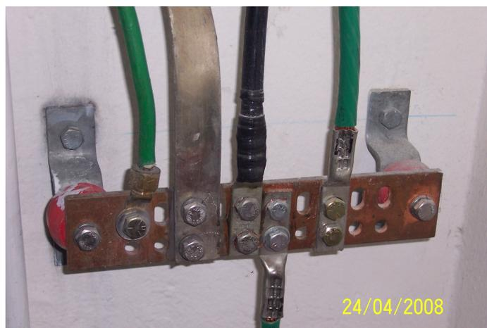
La TMGB debe ser una barra de cobre, con perforaciones roscadas según el estándar NEMA. Debe tener como mínimo 6 mm de espesor, 100 mm de ancho y largo adecuado para la cantidad de perforaciones roscadas necesarias para alojar
