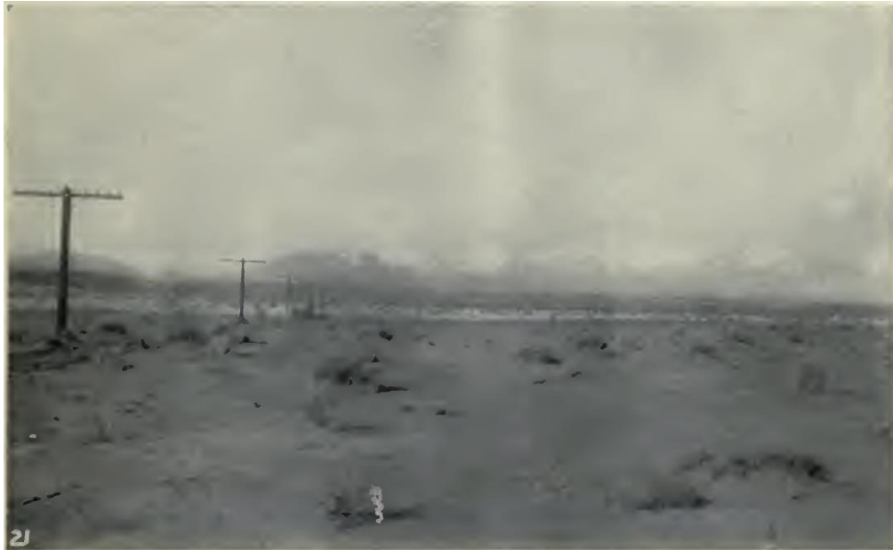
Tendido de cable de la línea transcontinental, atravesando el desierto de Nevada [100].
