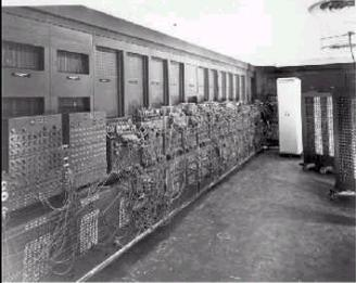
ENIAC estaba compuesto de 17.468 válvulas (más resistencias, condensadores, etc.), con 32 toneladas de peso, y ocupaba un espacio de 2,40 metros de ancho por 30 metros de largo. El calor de las válvulas elevaba la temperatura del local hasta los 50 °C.
