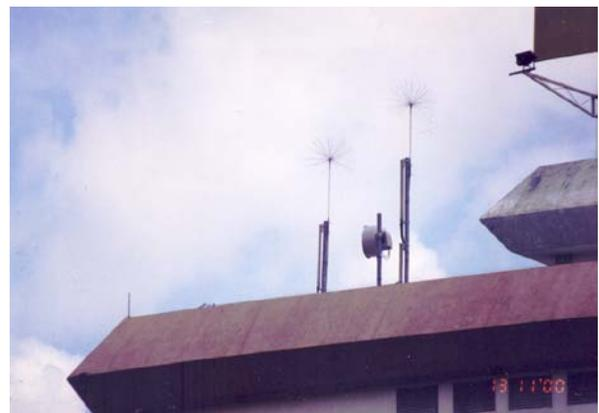
Fig. 9. Disipadores esféricos. Cortesía de Hartono [14].
