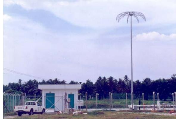
Fig. 7. Disipador en forma de paraguas para protección de una instalación de gas. Cortesía de Hartono [14].
