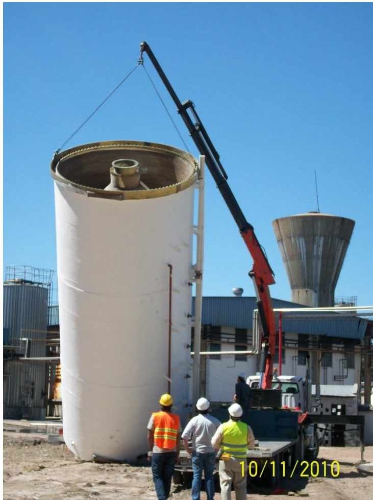
Fig.5 Montaje del reactor de 100 m 3 para tratamiento de efluente de industria láctea.
