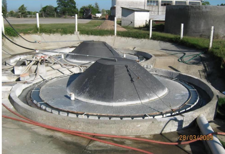
Fig.4 Exterior de los reactores enterrados para industria láctea
