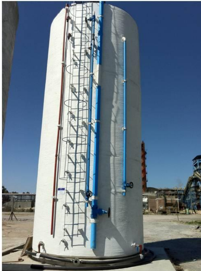
Fig. 6 Reactor de 100 m 3 para tratamiento de vinaza de destilería.
