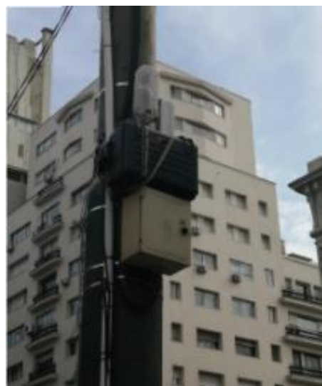
Figura 3. Punto de registro en la explanada de la IM
