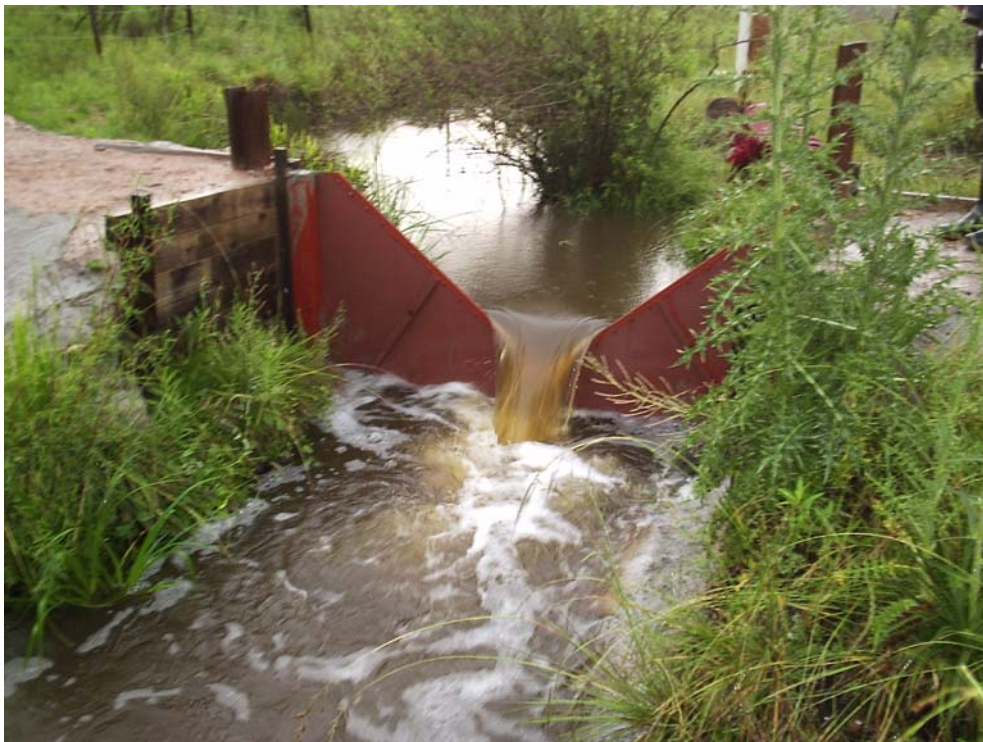
Figura 3. Vista, desde aguas abajo, del vertedero triangular de lámina delgada, instalado en el cierre de la microcuenca forestal
