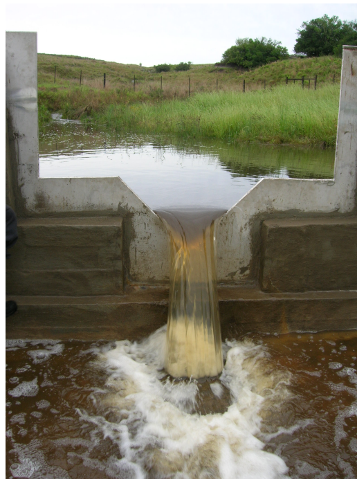
(c) Desde aguas abajo - NE
