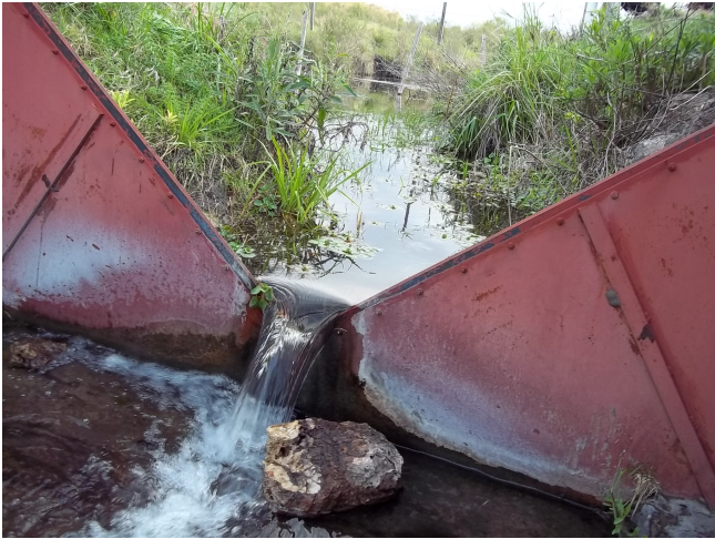
(a) Desde aguas abajo - DTf
