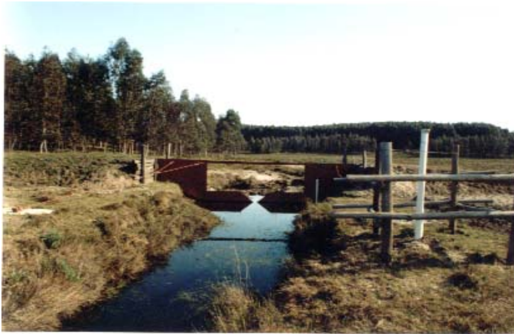
Figura 5. Vista, desde aguas arriba, del cierre ubicado en la microcuenca forestal, constituido por un terraplén provisto con vertedero de lámina delgada, de tipo triangular-rectangular, en su zona central
