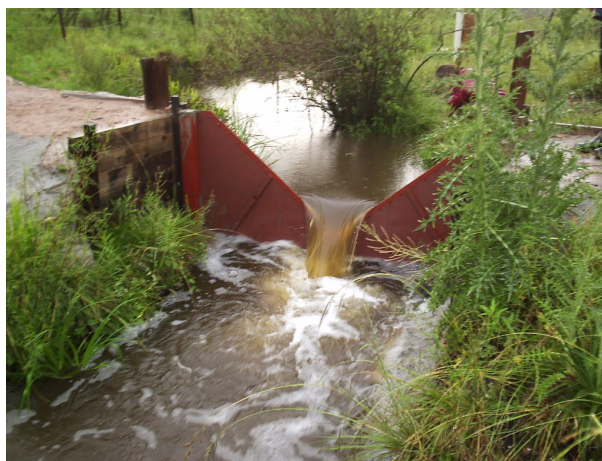
Figura 2.- Vista, desde aguas abajo, del vertedero triangular de lámina delgada, instalado en el cierre de la microcuenca forestal
