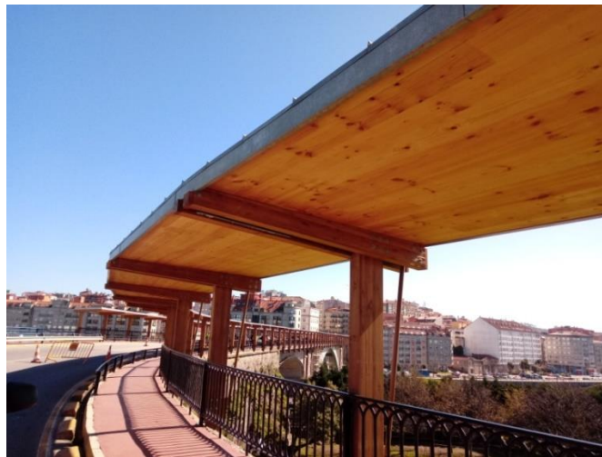
Figura 1: Vista general de la marquesina
