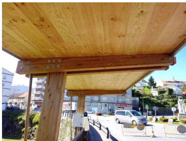
Figura: Detalle de la estructura de madera
