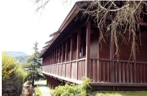
Figura 2: Detalle de la fachada oeste.
