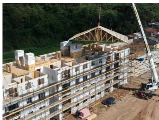
Figura 4: Residencial Pinhais Park, primeiros edifícios multifamiliares com 4 pavimentos, construídos pela TECVERDE. Fonte: TECVERDE
