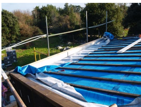
Figuras 7 y 8: Rastreles de duramen de castaño para la teja y placa de PE bajo el cobre.
