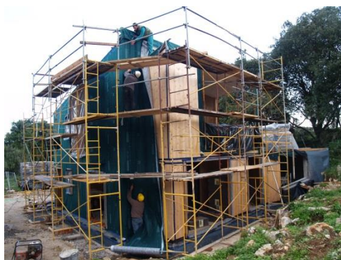
Figuras 5 y 6: Láminas y sellados de estanqueidad y solera del decking.
