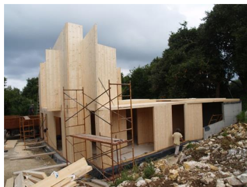
Figuras 1 y 2: Muros de carga de CLT y detalle de los arranques.
