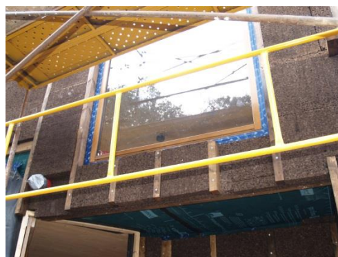
Figuras 9 y 10: Se prestó especial cuidado al sellado del perímetro de las ventanas.
