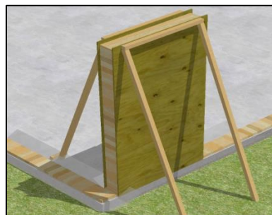
Figura 8: Montaje del panel sobre la solera inferior. (Toloza 2018).
