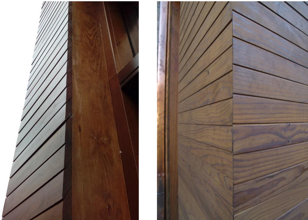
Figuras 13 y 14: Perfecto estado de las uniones entre las tablas de madera termotratada.
