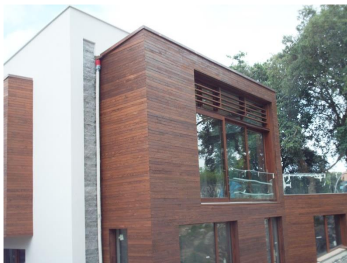
Figura 11: Lamas en bisel y encuentros en inglete para las galerías.
