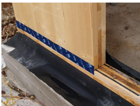
Figuras 5 y 6: Láminas y sellados de estanqueidad y solera del decking.
