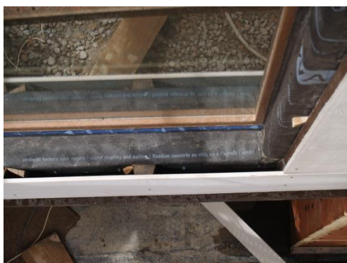
Figuras 9 y 10: Se prestó especial cuidado al sellado del perímetro de las ventanas.
