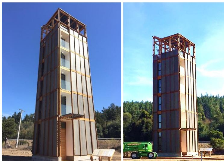
Figura 1: Torre Peñuelas (TP).
