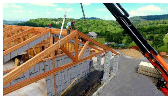
Figura 15: Casa do Sítio construída em MLC e woodframe em São Marcos-RS pela COMETA. Fonte: site COMETA
