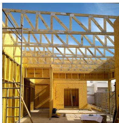
Figura 8: Residência de Alto Padrão construída em Limeira-SP, pela MG Homes – Fonte MGHOMES
