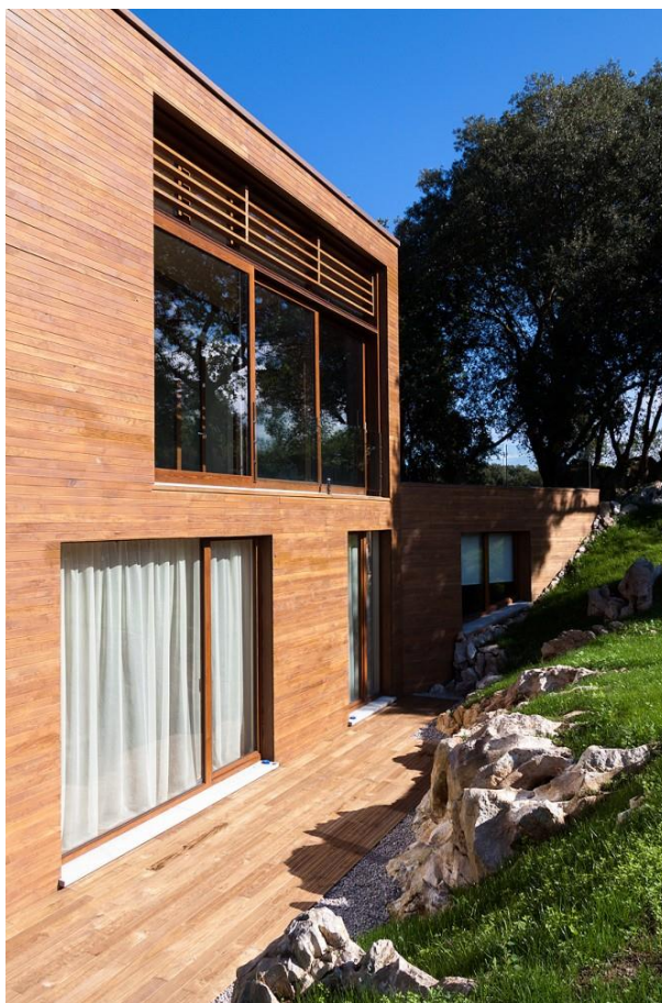
Figura 12: Terraza de fachada Sur en madera termotratada y protector UVA.
