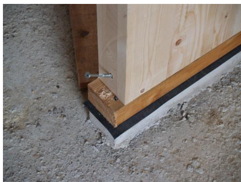
Figuras 1 y 2: Muros de carga de CLT y detalle de los arranques.
