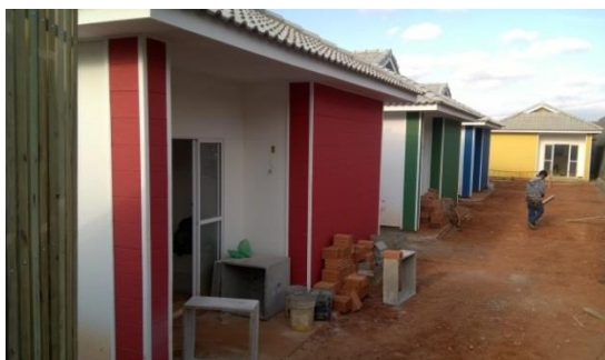
Figura 5: Condomínio de casas construído pela TETTI em Itapeva-SP – Fonte: do autor.
