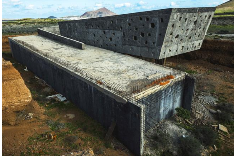
Figura 66: Foto estructura de hormigón preexistente, sector Aula didáctica
