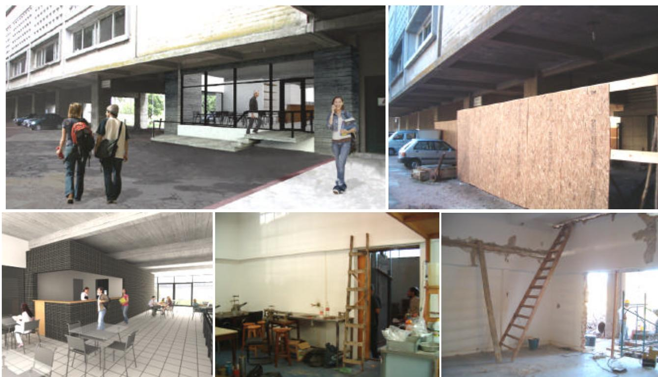
Se realizaron trabajos de replanteo, cercado perimetral de la obra y las zonas de carga y descarga de materiales y escombros e implantación de la empresa. Se está procediendo a realizar un cateo de los elementos estructurales y se realiza la demolición de muros.
