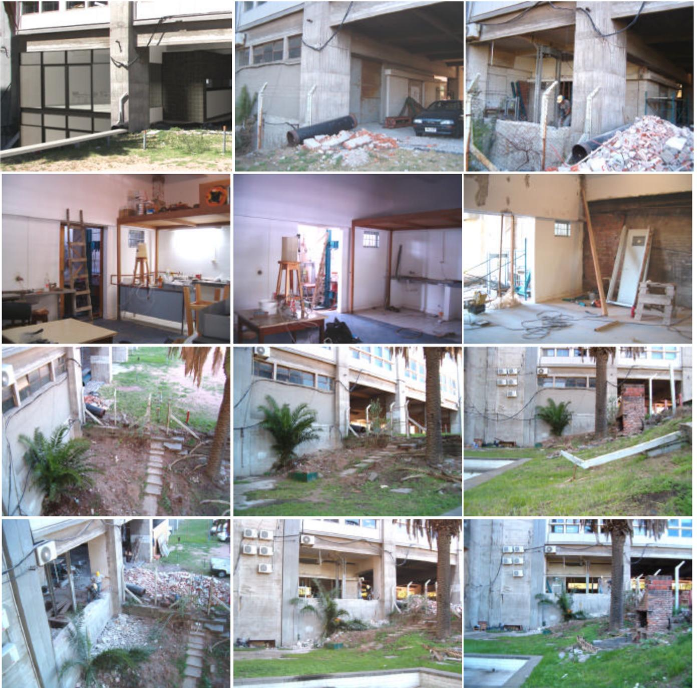
Debido a que en el local existían unas piezas de terminación realizadas en monolítico pulido y prefabricado, realizados en la década del '40, iguales a las existentes en otras áreas del edificio (lo que permite su reutilización), y por su valor histórico y de difícil fabricación, se retiraron las mismas con sumo cuidado, acción que permitió un importante porcentaje de recuperación de las mismas.
