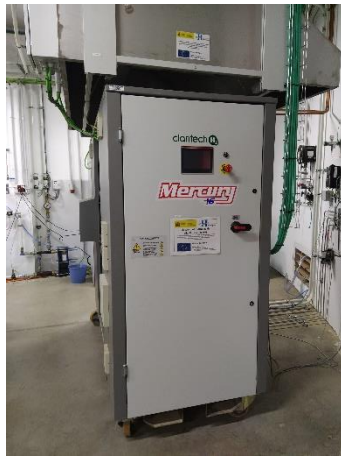
FUENTE: CNH2 – Electrolizador alcalino 60kW CLANTECH (suministro hidrogenera)
