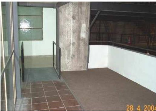
Construcción de rampa en hierro para lograr accesibilidad en el nivel 20,88 de los entrepisos metálicos del Cuerpo Norte.
