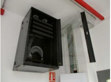
Se tendieron cables UTP para la instalación de 4 Access Points Wi-Fi, 2 cámaras de vigilancia CCTV, y una impresora. Se instaló un rack de 22 U, 600 x 550 mm y 108,2 cm de altura, con puerta delantera de vidrio, 1 PDU de 6 schukos y 4 organizadores para patcheras. Además se suministraron 96 patch cord de 5 feet, Categoría 6, PANDUIT.
