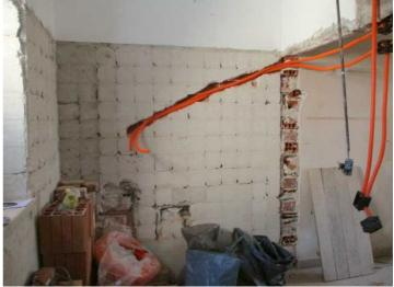
Se realizaron instalaciones eléctricas para heladera, microondas, máquina de café y otros electrodomésticos. Además se instaló un extractor y se colocaron 3 luminarias nuevas, de aplicar, de 2 x 120 cm, con doble louver parabólico, equipadas con tubos LED.
