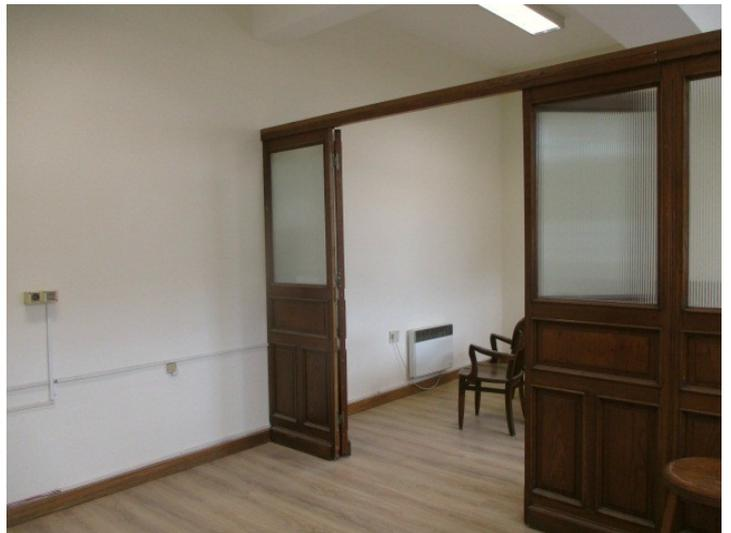
Se retiró la mampara de madera que divide los locales, se realizaron trabajos de albañilería, enduido y pintura en techo y paredes, se retiró el recubrimiento de madera de las cañerías pluviales y se colocó yeso verde. Posteriormente se colocó el piso flotante, zócales y se ajustó la puerta del local. Finalmente se volvió a colocar la mampara de madera.
