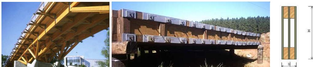
Figura 15. Puente con tablero de madera contralaminada (izqda.) (Flach, 2011) y puente con vigas de tablero contrachapado (dcha.) (Calil, 2006)
