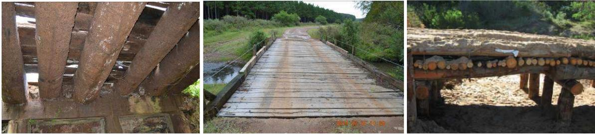
Figura 1. Vigas de madera resueltas con rollizos y entablado de madera
