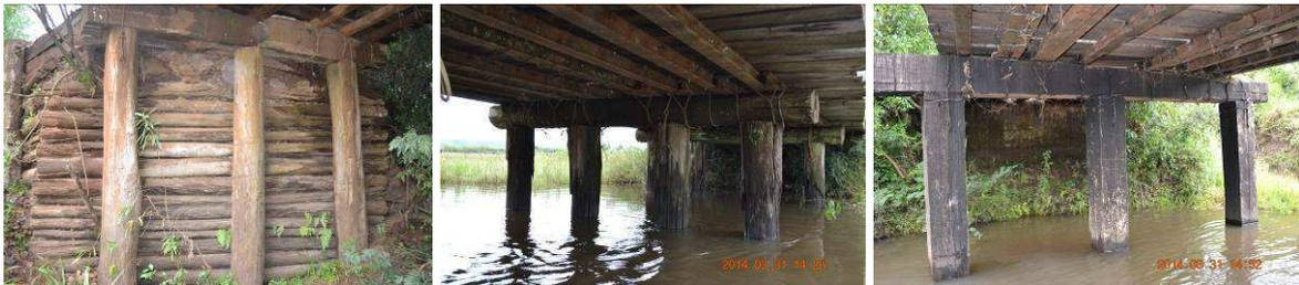
Figura 2. Estribos de madera y pórticos intermedios de madera formados por pilares y dinteles
