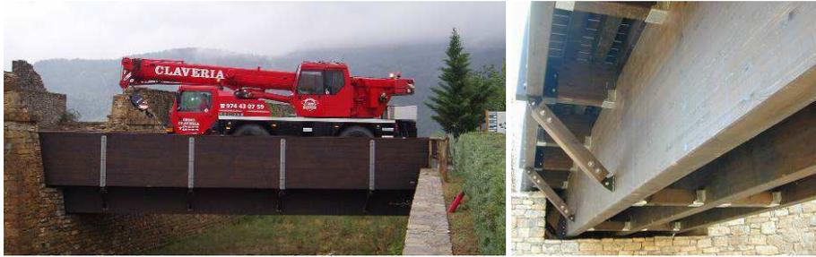
Figura 6. Puente en España con vigas rectas de MLE de 24 m de longitud
