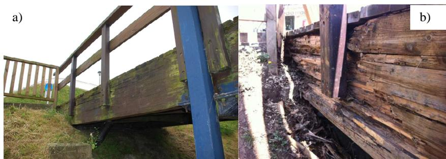
Figura 1. a) Contacto entre la viga principal y el terreno; b) Pudrición parda en una viga en contacto con el terreno.
