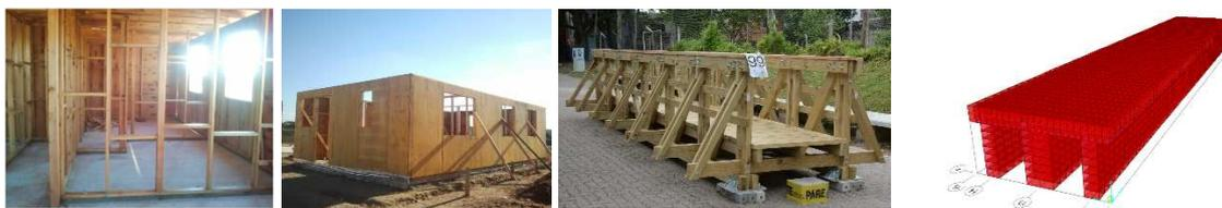
Figura 5. Sistemas constructivos en desarrollo en Uruguay: a) entramado ligero; b) reticulado; c) Puente con vigas de MLE y tablero con paneles CLT
