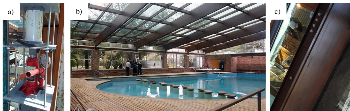
Figura 5: a) Dinamómetro y comparador colocado para medir la fuerza y flecha aplicada por el gato; b) estado de la cubierta y la piscina una vez finalizada la obra; c) detalle de la viga V4 terminada.
