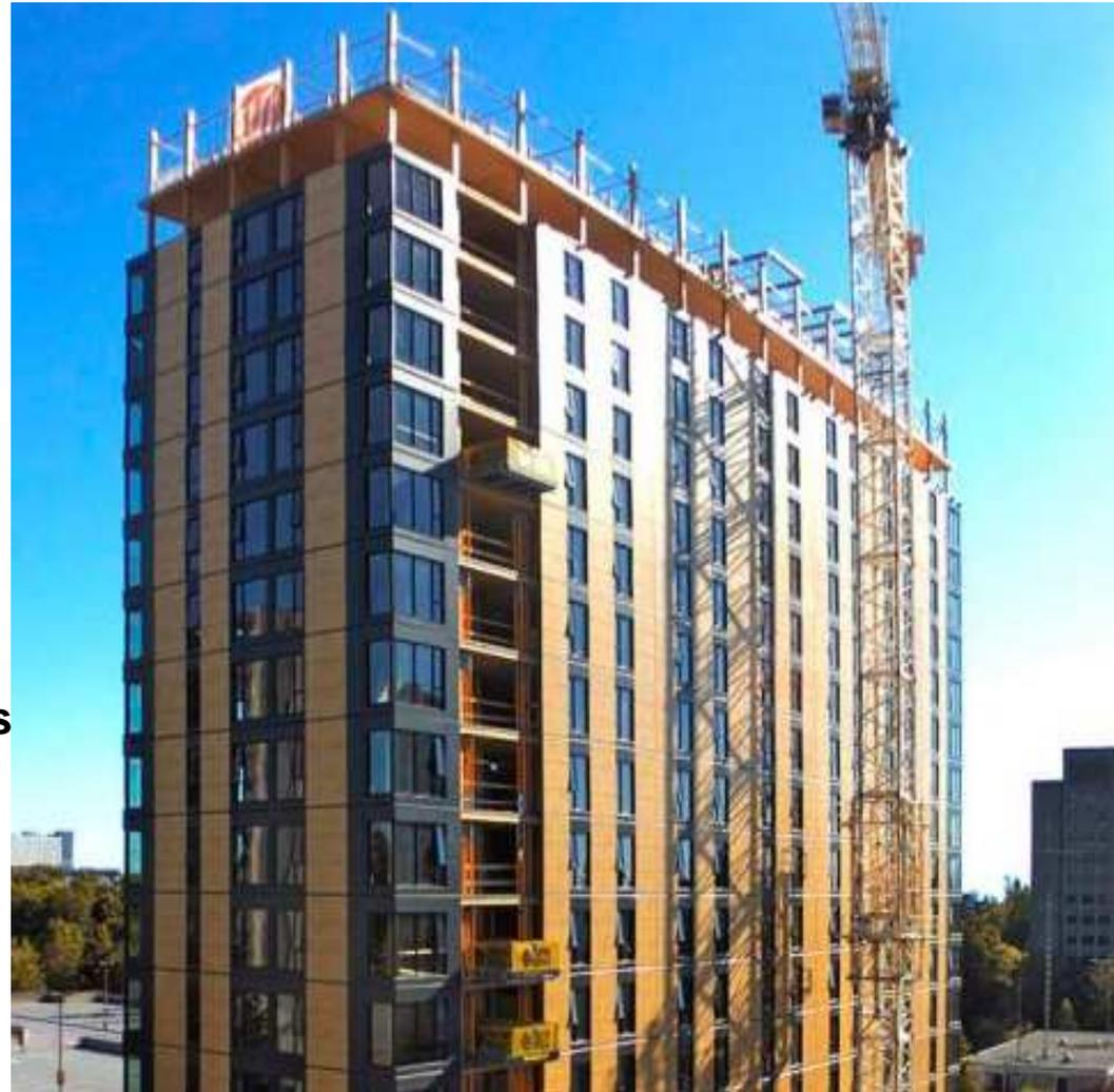
Paneles de madera contralaminada: usos en edificación en altura
