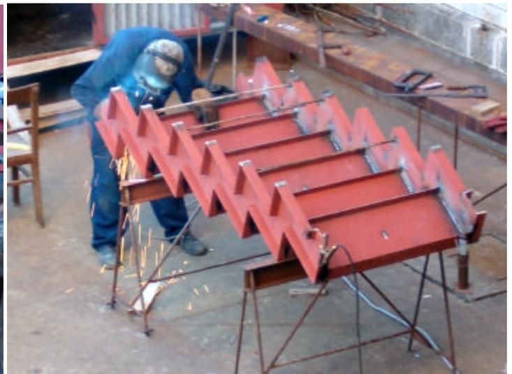
Ya se encuentra casi finalizado el sistema estructural del nivel 0 (planta baja), del nivel 100 (1er. nivel), 200 y 300. Se construyen las escaleras y se comenzó con la construcción de las mamparas de hierro. Ya se colocó el piso en el nivel 100.
