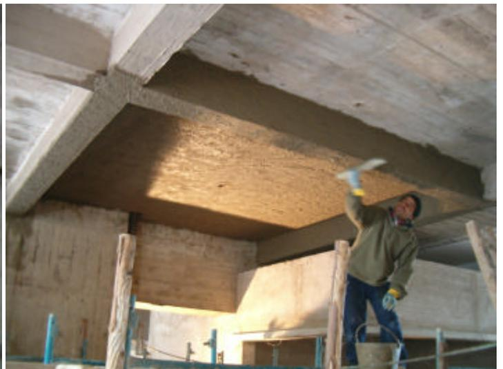
Además se realiza el arenado de los muros existentes a los efectos de limpiarlos de los materiales que impidan la adecuada adherencia de los revocos.
