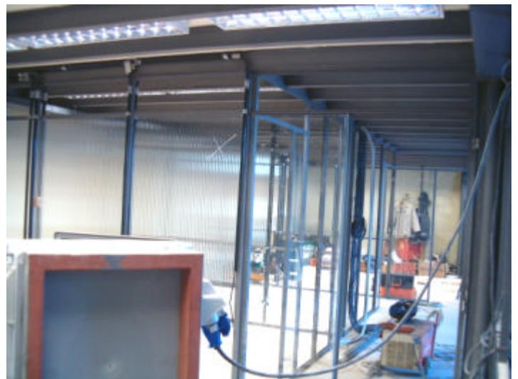
Se avanza con los trabajos de instalaciones eléctricas y colocación de luminarias. Casi se completaron los trabajos de carpintería y vidriería.
