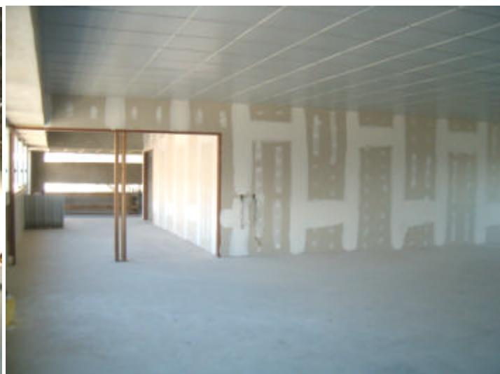
Ya se colocó el cielorraso en el nivel 200 y se están instalando las luminarias. Se está realizando el enduido de paredes e inmediatamente se comenzará con los trabajos de pintura.
