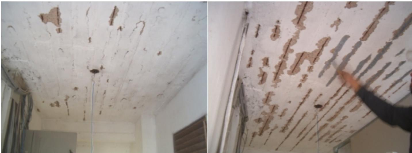
Además se retiraron los revoques sueltos y se realizó el tratamiento del hierro expuesto.
