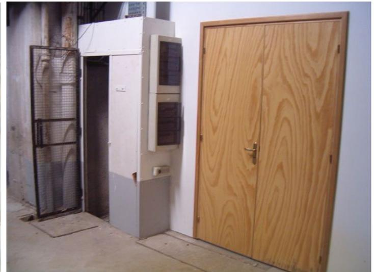
**Acceso a la azotea del Cuerpo Central.** Se adaptó y colocó una reja en la ventana ubicada en el acceso a la azotea del Cuerpo Central, a los efectos de impedir la caída accidental de personas u objeto a través de la misma, y hacia el hueco de la escalera del Cuerpo Central. Los trabajos fueron realizados por el Plan de Obras y Mantenimiento.
