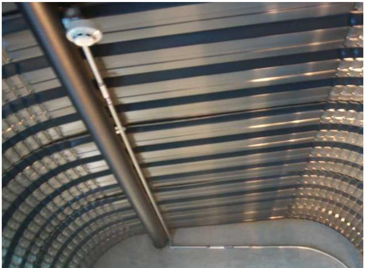
El Sistema de Detección y Alarma de Incendio cumple con la normativa NFPA 72 y con la normativa nacional vigente. Cuenta con una Central de Detección y Alarma de Incendios, 82 detectores de humo fotoeléctricos, analógicos direccionables en ambiente y 42 sobre cielorrasos, 13 estaciones manuales de alarma (pulsador), 46 sirenas de alarma y 10 aisladores de lazo.
