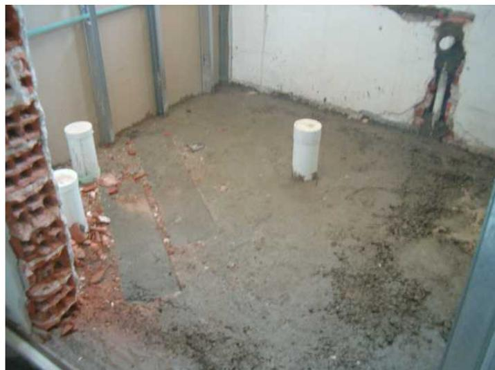
Ya se realizaron los trabajos de demolición y se comenzó con la construcción de los tabiques de yeso. Se realizaron casi totalmente las instalaciones sanitarias.
