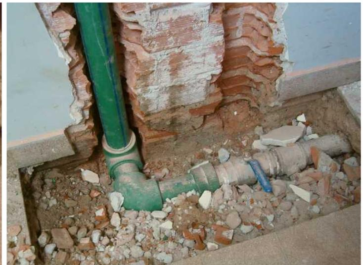
Se realizó un nuevo tendido de abastecimiento de agua potable debido a que las cañerías existentes tenían una importante corrosión y pérdidas que estaban generando patologías (humedad) en paredes, pisos y losas de hormigón en laboratorios, oficinas y salones-
