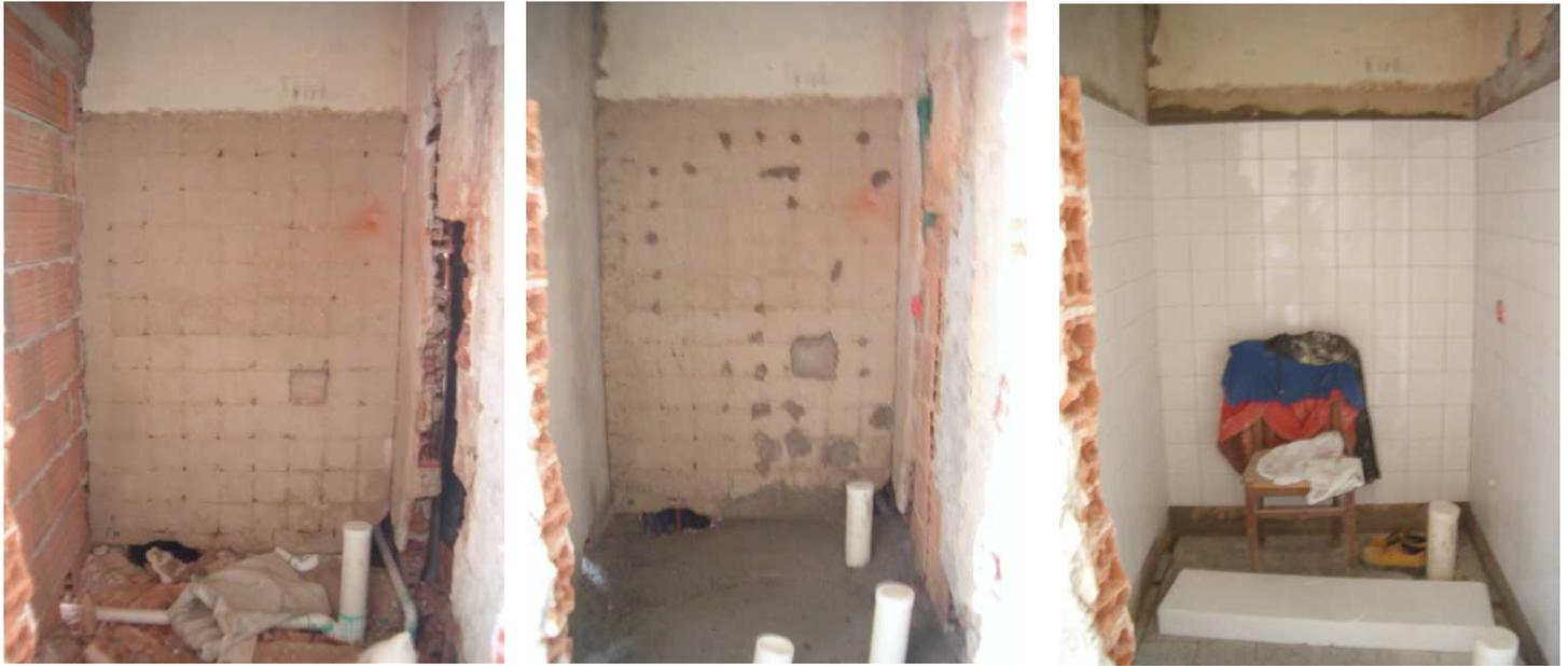
Los trabajos tienen un avance similar a los del ba1o del piso superior. Se realizaron la totalidad de los trabajos de alba1ilerfa, se colocaron los pisos monol3ticos y el revestimiento de paredes y se realizaron las instalaciones sanitarias
