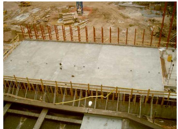
Vistas del hormigonado de la losa entre la planta baja y la planta alta.
