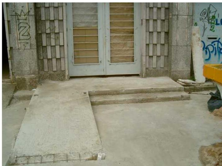
Ya se demolieron los escalones para permitir el acceso en sillas de ruedas, se reconstruyó la escalera y se construyó la rampa exterior
