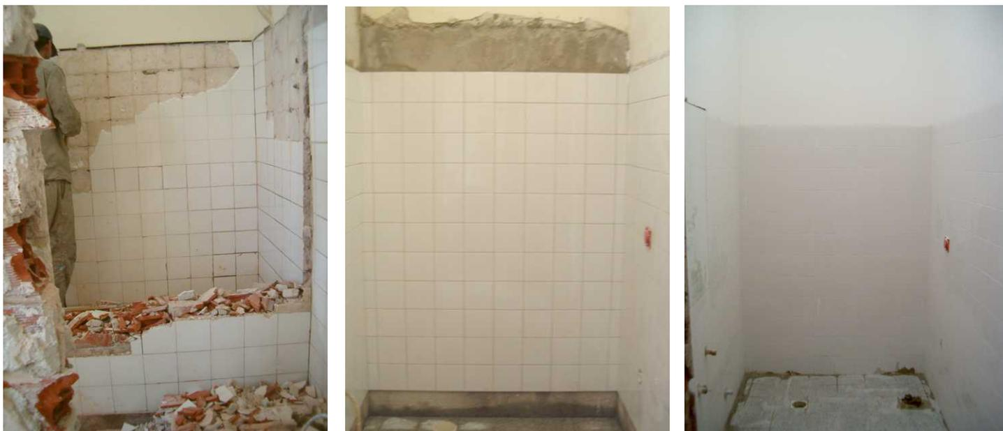
Ya se realizaron todos los trabajos de albañería, revestimiento de paredes, instalaciones sanitarias, colocación de piso monolítico, pulido del mismo y enduido y pintura de las paredes. También se colocaron los espejos. Solo resta la instalación de los artefactos y la colocación de las puertas.
