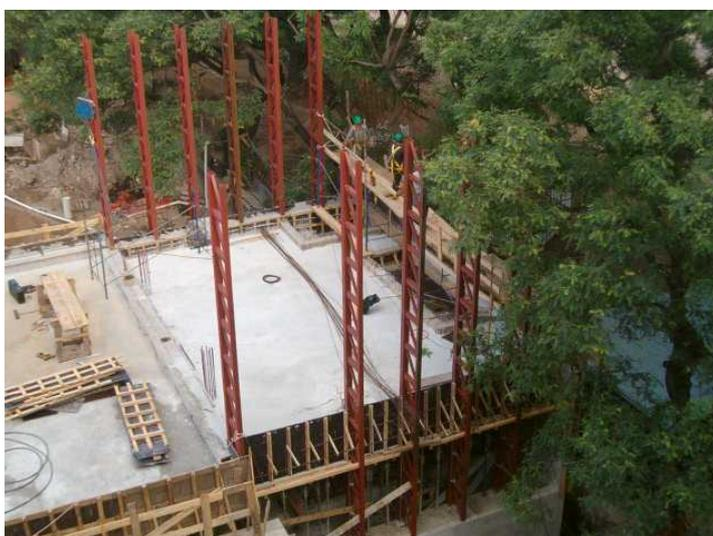
Durante este mes se hormigonó parte del contrapiso de planta baja y el 50% de la losa que oficia de azotea de la planta alta. En las losas ya se incluyeron las canalizaciones para las instalaciones eléctricas y sanitarias.
