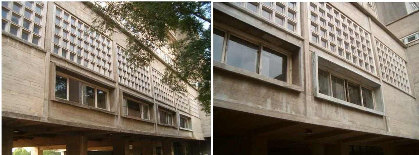
Los trabajos implican un hidrolavado de las fachadas, el posterior picado, tratamiento y reconstrucción de las zonas afectadas, y la pintura de las mismas a los efectos de proteger mejor los hormigones frente a las condiciones ambientales a las cuales están expuestos.
