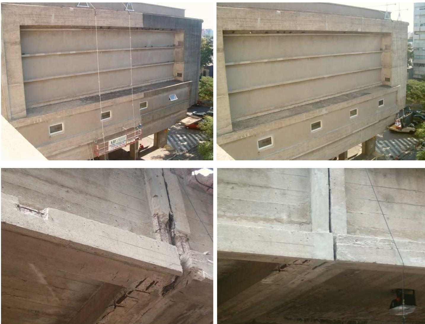
Se realizó el hidrolavado de las paredes laterales Sur del Salón de Actos y Este del Cuerpo Central. También se realizó el retiro de los hormigones flojos, se realizó el tratamiento del hierro, se repararon las superficies de hormigón y se comenzó con la aplicación de un protector transparente en las paredes.
