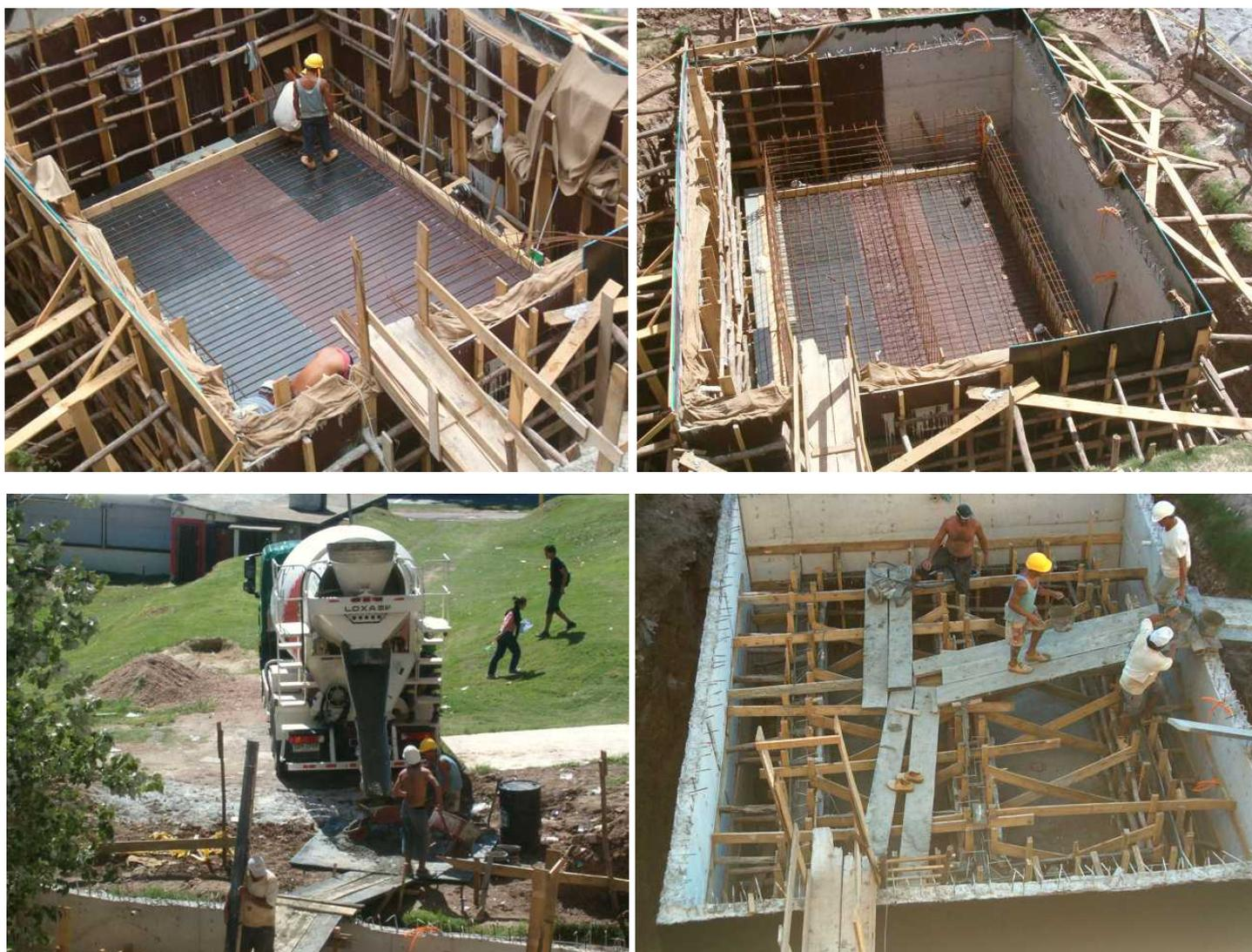
Se finalizó la construcción del muro de contención y del piso y paredes del tanque. Además se comenzó con la impermeabilización del muro.
