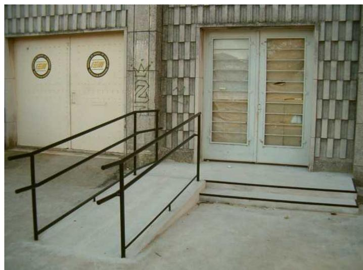
Los trabajos incluyeron la construcción de una rampa en el estacionamiento del Cuerpo Sur, la eliminación de 3 escalones de una escalera interior, la apertura de una pared para generar un acceso inmediato a los institutos de Ingeniería Eléctrica y de Ensayo de Materiales, y adecuaciones menores en un laboratorio del IEM.
