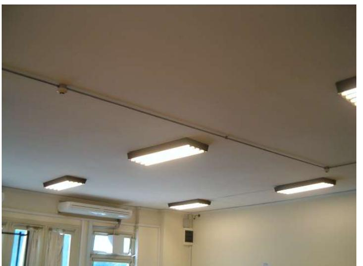
**Mejora de la iluminación en el laboratorio abierto de Mecánica de los Fluidos.** Se realizó por parte del Plan de Obras y Mantenimiento la colocación de luminarias para mejorar los niveles de luz en el laboratorio abierto de Mecánica de los Fluidos, ubicado en el 3er. Subsuelo del Cuerpo Norte.
