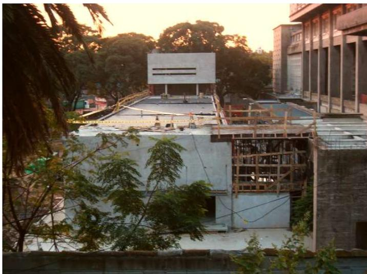
Se finalizaron los trabajos de hormigonado del tanque de agua y la senda peatonal entre el edificio para el InCo y el Cuerpo Norte de FING donde se ubica el IMFIA.
