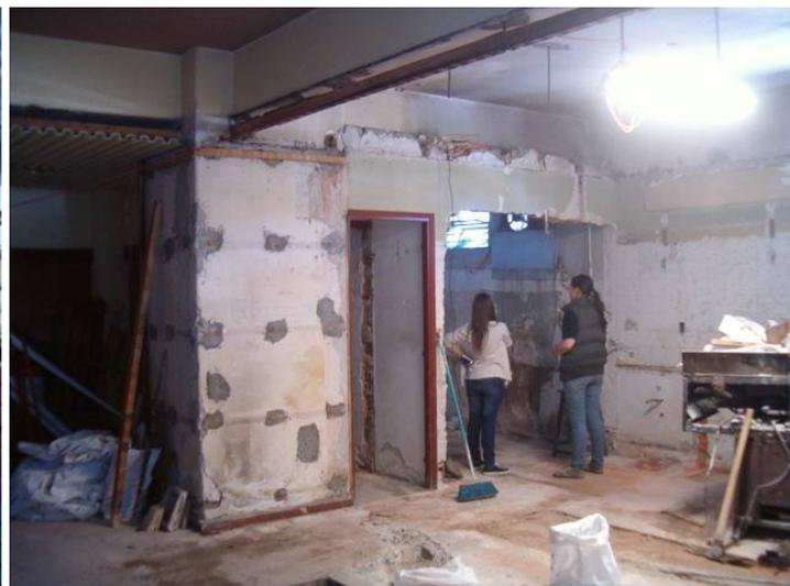
Los trabajos que se comenzaron recientemente avanzan de acuerdo a lo planificado. Ya se realizaron los trabajos de demolición (de mesadas) y retiro de cielorraso, revestimiento de madera y cerámicos, equipamiento, y se avanza con las instalaciones sanitarias, de abastecimiento de agua, eléctrica y de red de datos.
