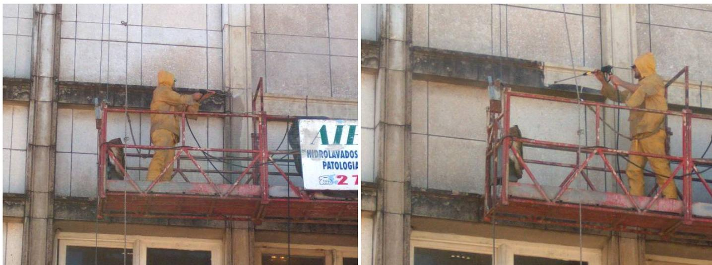
El tratamiento consiste en el retiro de los hormigones flojos, el picado de las zonas próximas hasta descubrir las armaduras completamente, la limpieza y tratamiento de las armaduras, la aplicación de mejoradores de adherencia y el llenado con hormigón, el curado del mismo y la terminación superficial del hormigón. Posteriormente al trabajo de reparación se realiza un hidrolavado de la fachada y se aplica una pintura transparente.
