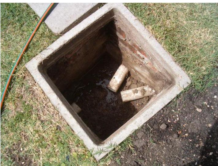
**Arreglos en estacionamiento del Cuerpo Sur.** A los efectos de promover el uso del referido estacionamiento, se están realizando diferentes trabajos. Uno de ellos es la construcción de tapas para la acometida de los cables a la subestación de UTE.
