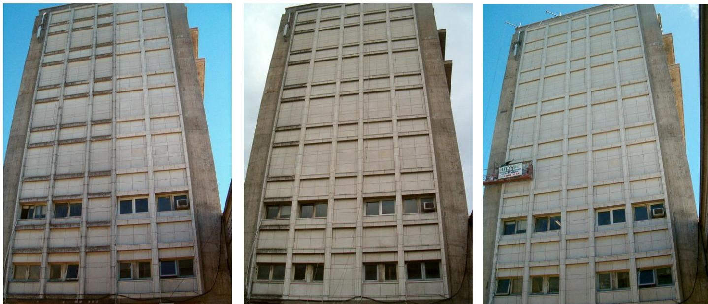
El tratamiento consiste en el retiro de los hormigones flojos, el picado de las zonas próximas hasta descubrir las armaduras completamente, la limpieza y tratamiento de las armaduras, la aplicación de mejoradores de adherencia y el llenado con hormigón, el curado del mismo y la terminación superficial del hormigón. Posteriormente al trabajo de reparación se realiza un hidrolavado de la fachada y se aplica una pintura transparente.
