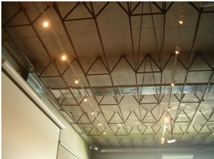
**Luminarias de aulas.** Se realizó la separación en dos líneas del comando de las luminarias de las aulas 106, 108, 109, 110 y 111. Los trabajos fueron realizados por la empresa Javier Pardo. Estos trabajos permiten apagar la mitad delantera del salón mientras se están proyectando imágenes sobre las pantallas, lo cual mejora la visibilidad de las mismas.
