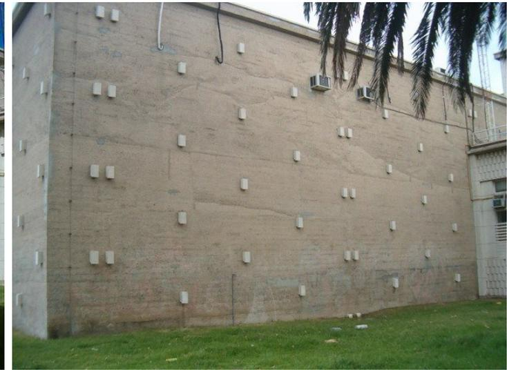
El tratamiento consiste en el retiro de los hormigones flojos, el picado de las zonas próximas hasta descubrir las armaduras completamente, la limpieza y tratamiento de las armaduras, la aplicación de mejoradores de adherencia y el llenado con hormigón, el curado del mismo y la terminación superficial.
