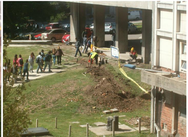
Con la realización de estos trabajos se comienza a revertir la situación existente desde la inauguración del edificio, donde los cableados de telefonía y fibra óptica entran por el Cuerpo Sur, suben hasta el techo de dicho sector, bordean el mismo, para luego ir por encima del puente que comunica con el Cuerpo Central, y luego bordeando éste, hasta la bornera ubicada en los accesos de la nueva cantina.
