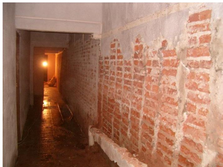
Retiro de revoques en muro de contención para impermeabilizar los mismos.
