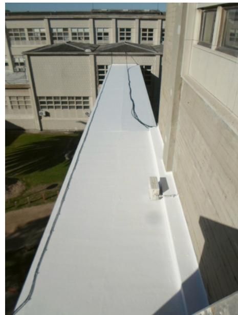
**Mantenimiento de impermeabilización de la azotea del hall de Planta Baja.** Se realizaron también trabajos de mantenimiento de la impermeabilización de la referida azotea. Se removieron los sectores afectados y se procedió a la pintura de la azotea con impermeabilizante blanco fibrado. Los trabajos en este caso también fueron realizados por la empresa Constrac Ltda..
