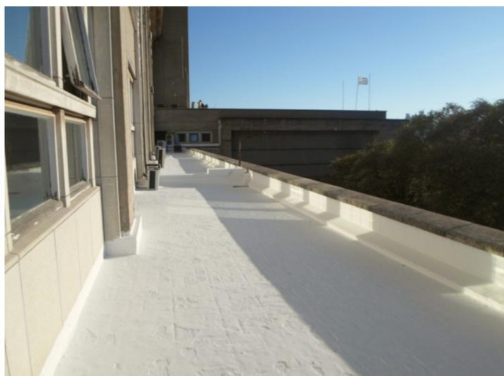
**Mantenimiento de impermeabilización de dos sectores de la azotea del 3er SS del Cuerpo Norte.** Se realizaron trabajos de mantenimiento de la impermeabilización de las referidas azoteas. Se removieron los sectores afectados y se procedió a la pintura de la azotea con impermeabilizante blanco fibrado. Los trabajos fueron realizados por la empresa Constrac Ltda..
