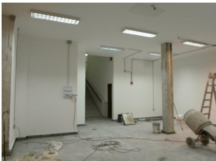
Los trabajos implicaron también la colocación de un cielorraso de yeso en el hall, la colocación de piso monolítico en la escalera, la pintura del local e instalaciones eléctricas.
