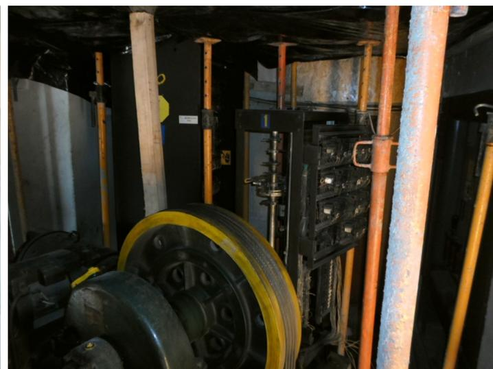
Se pretende mediante el cerramiento de la máquina del ascensor en funcionamiento, poder avanzar en los trabajos de desinstalación de uno de los ascensores e instalación del nuevo, para así luego trabajar en la segunda de las unidades.
