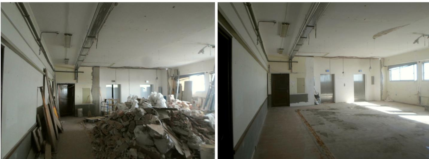
Los trabajos realizados hasta la fecha correspondieron a la demolición de tabiques de yeso, muros de mampostería, retiro de equipos de aire acondicionado y aberturas y reubicación de bandeja portacables. Los trabajos fueron realizados por las empresas Constrac Ltda. , Walter O. Rodríguez y Javier Pardo.
