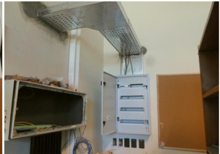
**Tendido de líneas a Tablero General del Cuerpo Sur.** Adicionalmente al trabajo de renovación del referido tablero, se realizaron tendidos de líneas a los efectos de independizar diferentes laboratorios que actualmente están todos derivados del tablero general del Laboratorio de Máquinas Eléctricas: Fotometría, Medidas Eléctricas y Proyecto.
