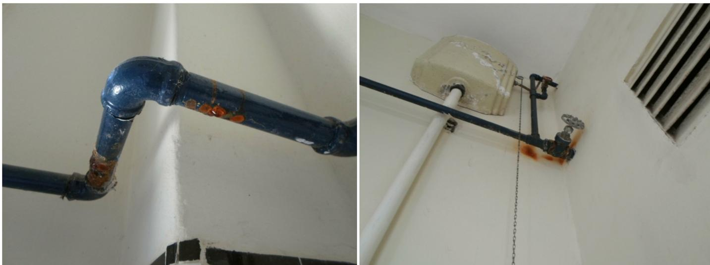
Los trabajos implicaron la realización a nuevo de todo el tendido de abastecimiento de agua, revestimientos, sustitución de grifería y cisternas, revoque, enduido y pintura de paredes y techo.
