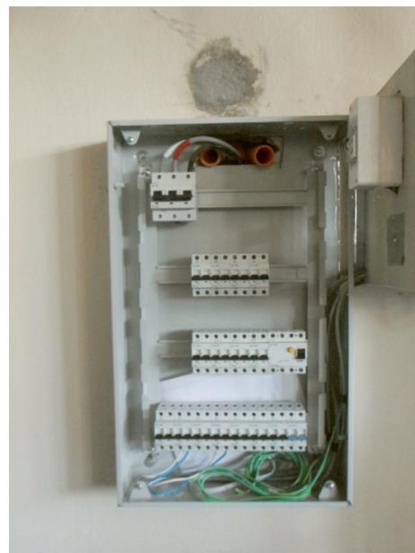
Los trabajos implican la realización a nuevo de las instalaciones eléctricas y el retiro de decenas de metros de conductores de cobre, forrados en tela y con recubrimiento de plomo.
