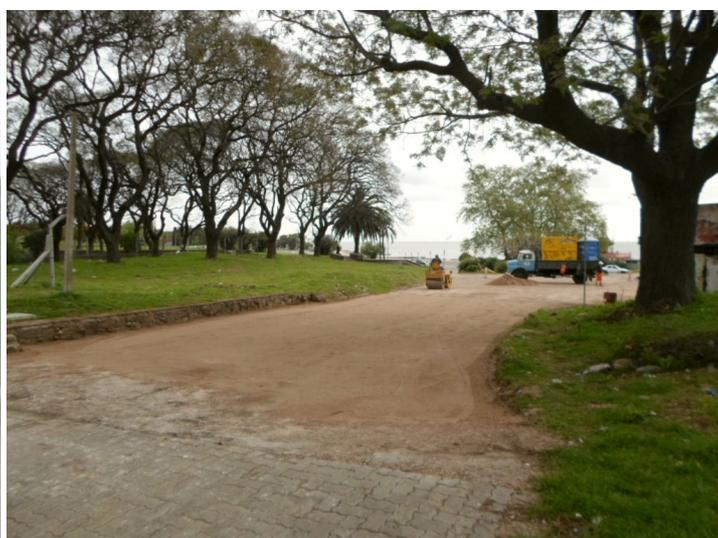
La senda vehicular será de adoquines de hormigón (e: 10 cm) asentados en una capa de arena. Esta senda será continuación de la Senda Landoni y desembocará en el estacionamiento de Rummy mediante un rebaje de cordón y rampa cuyo desarrollo no superará el ancho del cantero enjardinado.
