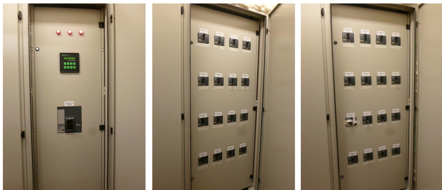
Actualmente se realizan trabajos menores (colocación de puertas, tapas laterales, cartelería en acrílico para identificación de interruptores, etc.).
