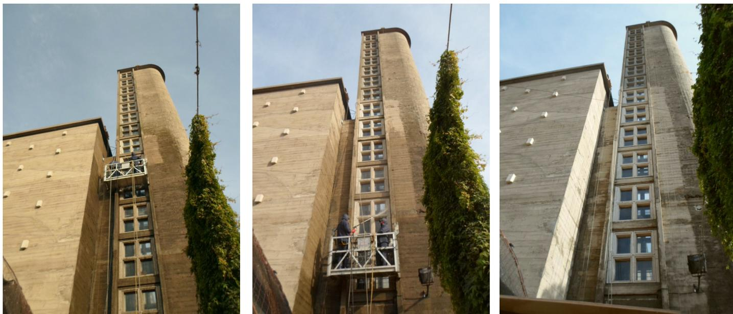
Debajo del Cuerpo Central se realiza la reparación de los hormigones en pilares y cielorrasos y se realizó el hidrolavado.
