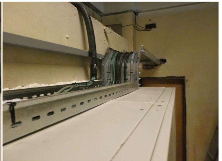
Los trabajos fueron realizados por la empresa Habilis S.A., por un monto de \$ 555.100, impuestos incluidos. Los trabajos implicaron la desconexión de todas las líneas que salían del tablero existente, la identificación de las mismas, el retiro del herrera metálica, la instalación del nuevo tablero y su conexión. También se realizaron trabajos menores (colocación de puertas, tapas laterales, cartelera en acrílico para identificación de interruptores, etc.).
