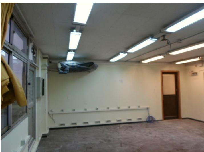
Se realizó el retiro de las instalaciones que afectaban la apertura de nuevas puertas que comunican las oficinas entre sí. Además se realizó la colocación de las mismas, se realizaron trabajos de albañilería, enduido y pintura.
