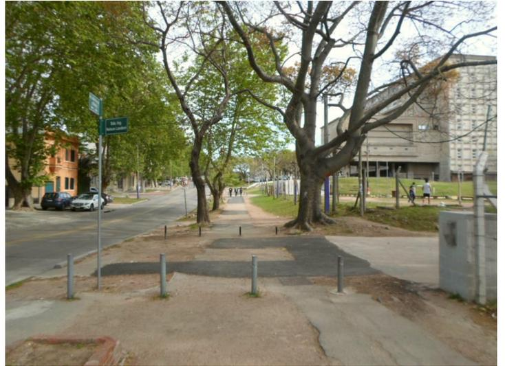
**Construcción de senda peatonal entre los edificios Anexo del IET y el Polifuncional Massera.** Al igual que en las otras sendas peatonales, sobre la base de balasto compactado, se realizó una imprimación y dos capas de riego asfáltico: la primera capa está compuesta por pedregullo 10mm y RC2 (1.5 lt x mt<sup>2</sup>). En la segunda capa se utilizó RC2 (máx 1 lt x mt<sup>2</sup>) y pedregullín granítico rojo.
