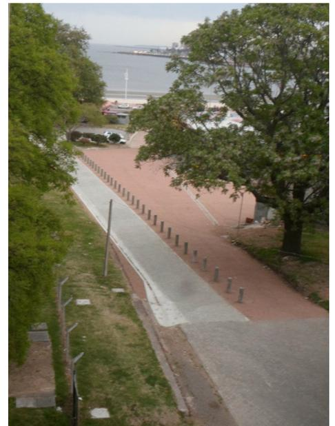
La senda vehicular es de adoquines de hormigón (de 10 cm de espesor) asentados en una capa de arena. Esta senda es continuación de la Senda Landoni y desemboca en el estacionamiento de Rummy mediante un rebaje de cordón y rampa cuyo desarrollo no superará el ancho del canchero enjardinado.
