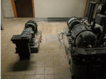
Resta realizar los tendidos eléctricos hasta el nuevo tablero, y de éstos hacia los motores.
