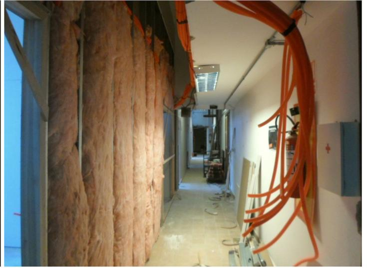
En el Laboratorio de Inestabilidad en Fluidos ya se retiraron las mamparas de madera, se retiró el revestimiento de la mesada, se colocó el tabique de yeso y la puerta, se realizaron las canalizaciones de las instalaciones eléctricas y de red de datos y sanitaria.
