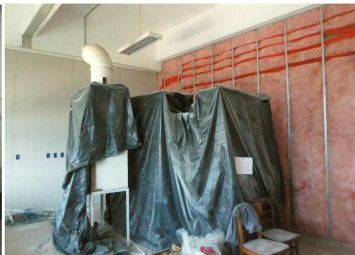
En el Laboratorios de Física de las Partículas también se retiró la mampara de madera, se demolió la mesada y se colocaron baldosas monolíticas en el piso, se colocó el tabique de yeso, se canalizaron las instalaciones eléctricas y de redes de datos, sanitaria y se colocó la puerta.
