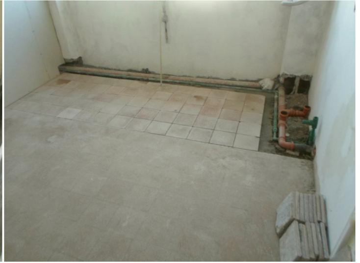
En el Laboratorio de Efecto Mossbauer también se retiró la mampara de madera, se demolió la mesada y se colocaron baldosas monolíticas en el piso, se colocó el tabique de yeso, se canalizaron las instalaciones eléctricas y de redes de datos, sanitaria y se colocó la puerta. Además se realizaron reparaciones de revoque y ya se pintó el techo.
