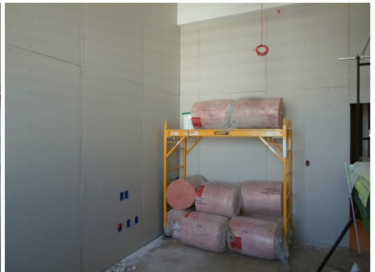
En uno de los Laboratorios de Física de Estados Sólidos también se retiró la mampara de madera, se sustituyeron baldosas monolíticas en el piso, se retiró el revestimiento de la mesada, se colocó el tabique de yeso, se canalizaron las instalaciones eléctricas y de redes de datos, sanitaria y se colocó la puerta (en este caso de 2 hojas a los efectos de poder retirar el equipamiento allí instalado en caso que sea necesario).
