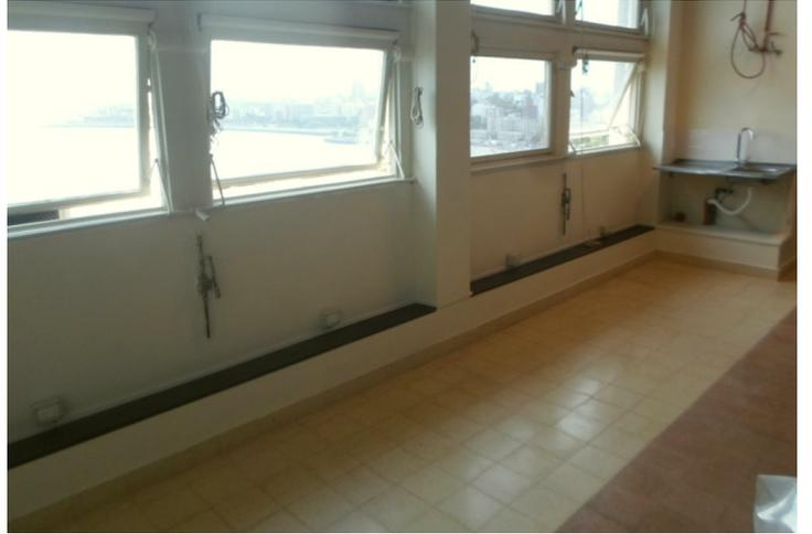
En Laboratorio de Óptica se demolieron 2 mesadas y se colocaron baldosas monolíticas nuevas en el piso. Además se realizaron reparaciones de los revoques, enduido, sanitaria y se pintó el local. Además se instaló una piletta de acero inoxidable y las mesadas existentes se revistieron con granito gris mara.
