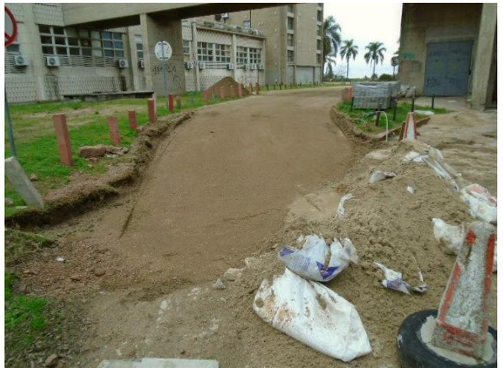
En el acceso se realizó una caja, donde se realizó el retiro de material contaminado, suministro, desparramando y compactando de una sub base con 15 cm de balasto, y la posterior colocación de adoquines de hormigón de 6 cm de altura.
