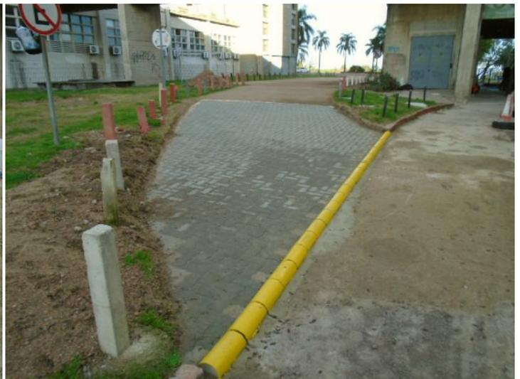
La colocación de adoquines de hormigón responde a la necesidad de minimizar los costos que anualmente tenemos de mantenimiento del referido estacionamiento, en particular en el acceso, donde el deterioro es importante por el arrastre que las ruedas de los vehículos realiza al hacer el giro.
